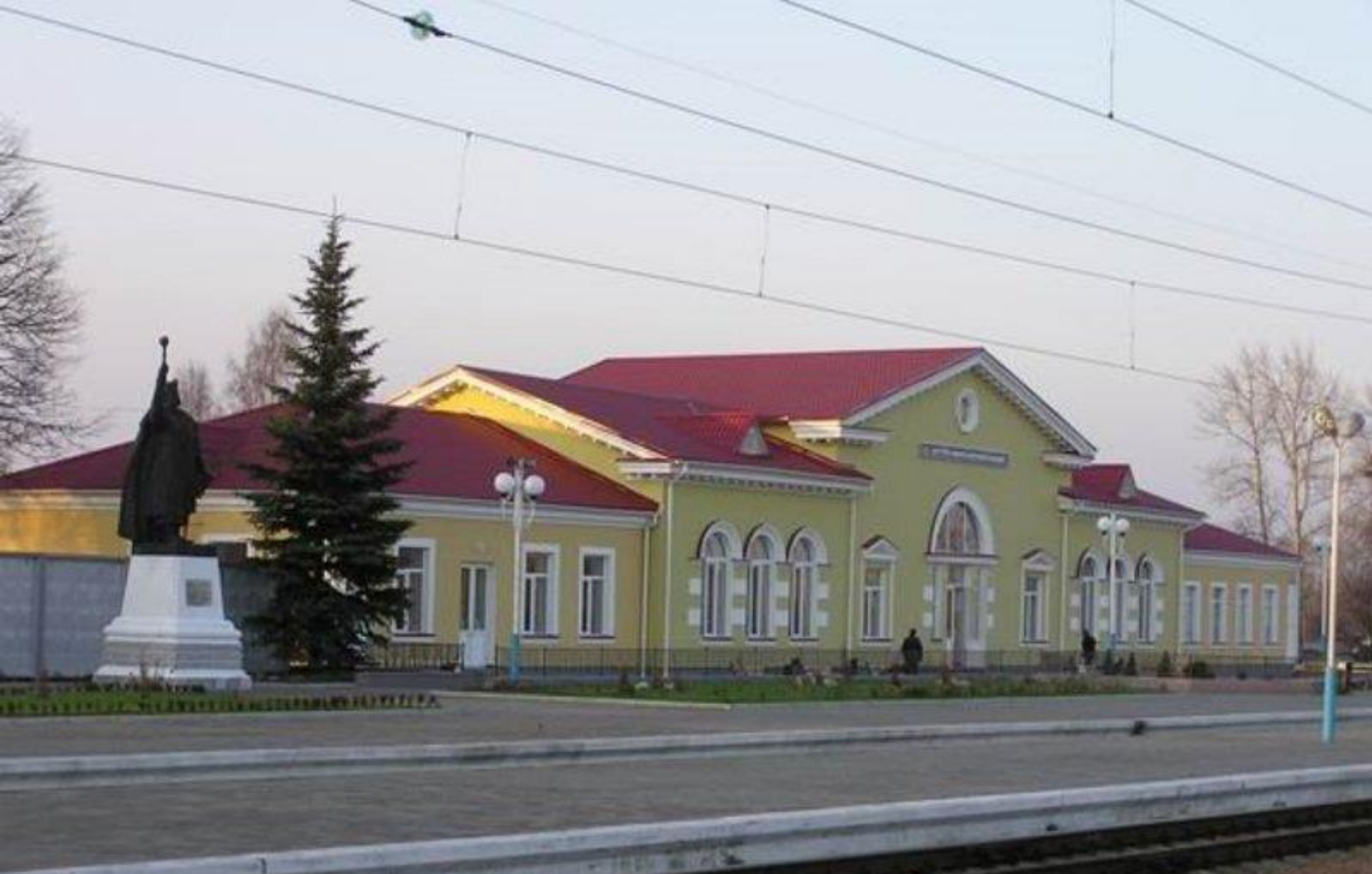
СТАНЦІЯ ХУТР МИХАЙЛІВСЬКИЙ вузлова залізнична станція на кордоні, збудована в 1893 році. На даний момент знаходиться в м. Дружба (Ямпільський район)
